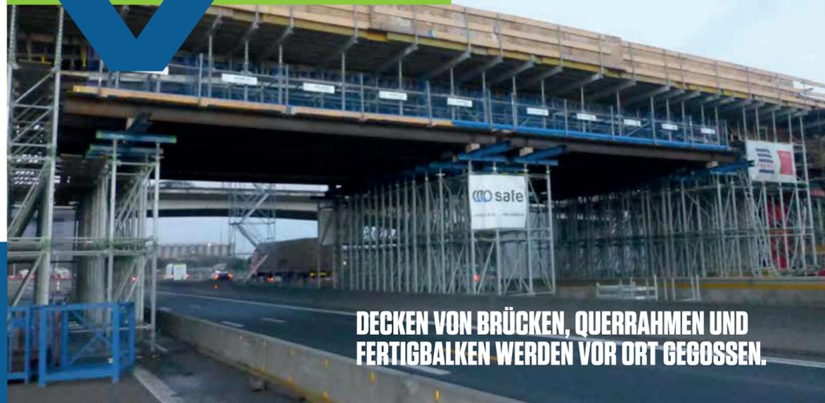
DECKEN VON BRÜCKEN, QUERRAHMEN UND FERTIGBALKEN WERDEN VOR ORT GEGOSSEN.
