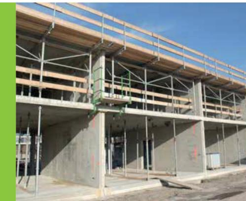
Geeignet für Raumbreiten bis zu ca. 8 Meter und belastbar bis zu 40 kN
